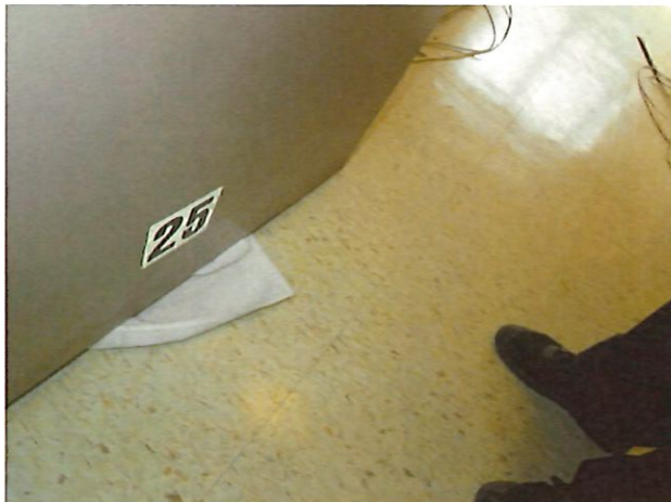
55. Unit 25 One Bedroom One Bathroom (vacant): Front Door
