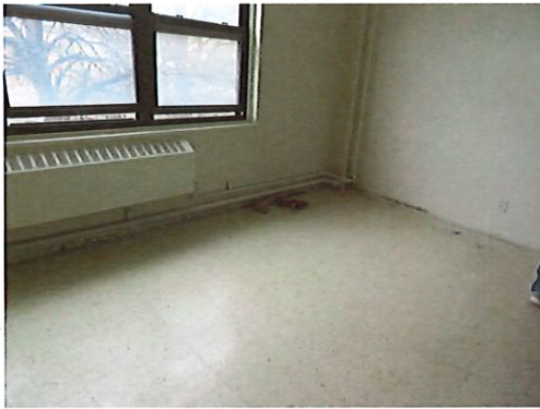
Unit 25 One Bedroom One Bathroom (vacant): Bedroom
