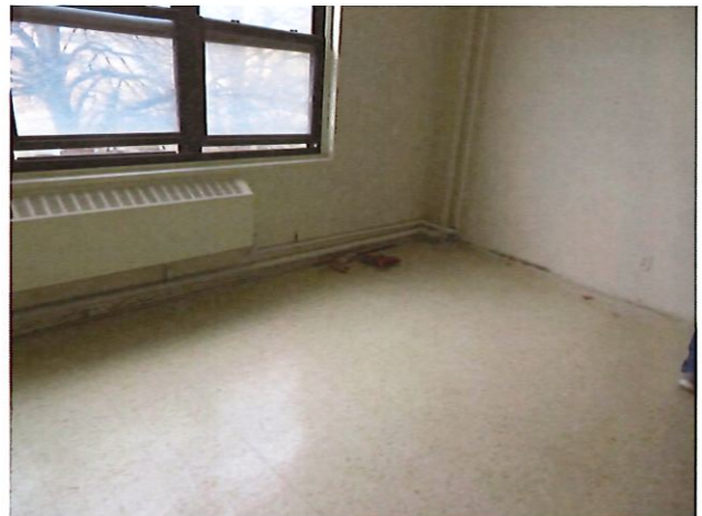
56. Unit 25 One Bedroom One Bathroom (vacant): Bedroom
